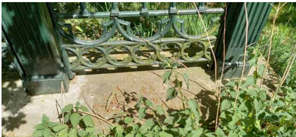
Afb. 7.1 De betondorpel die boven het maaiveld uitsteekt.
